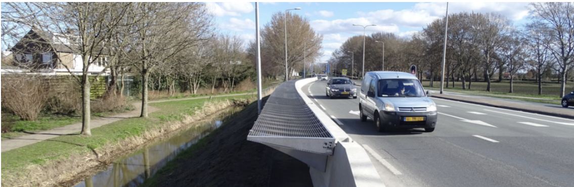
Combinatie van een betonnen barrière en metalen diffractor. Beeld: 4Silence
